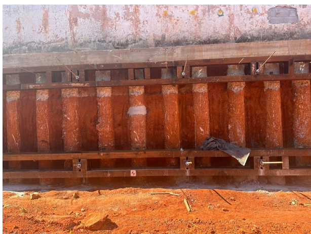
Imagens 09 e 10 – Protensão com atirantamento e perfis metálicos para contenção do aterro vizinho
