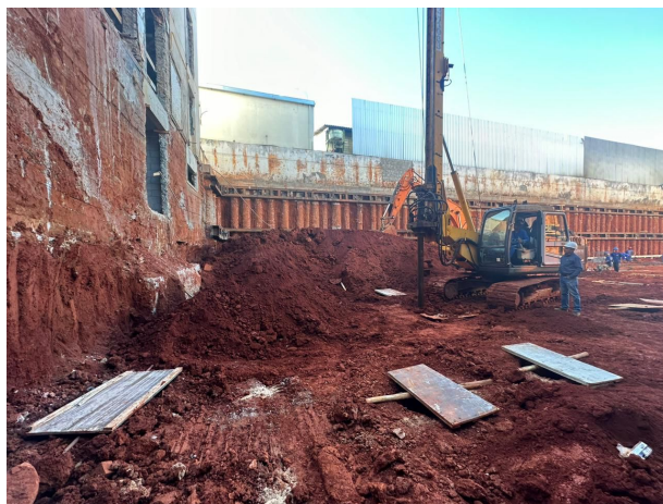
Imagens 07 e 08 – Fundação do Bloco existente após início de escavação
