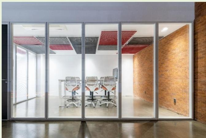
Divisória para ambientes, tipo piso teto vidro único total, com estrutura confeccionada em alumínio anodizado fosco em módulo padrão de 1250 mm de largura por até 2700
