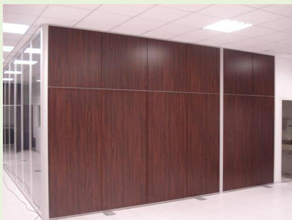
Divisória para ambientes, tipo piso teto com painel cego em MDP e bandeira superior, com estrutura confeccionada em alumínio anodizado fosco em módulo padrão de 900 mm de largura por até 2700 mm de altura (pé direito) e na espessura de 90 mm, com fechamento in loco, quando preciso, sob medida variável de acordo com o projeto. Composta por: Módulos de 900 mm de largura e altura de 2700 mm, fechamentos in loco, sob medida de acordo com o projeto previamente realizado.
