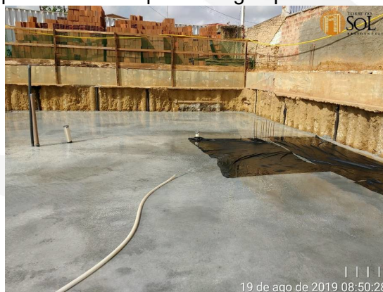
Cura úmida sendo aplicada de forma constante
